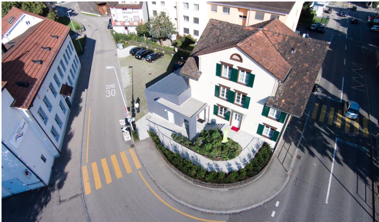
Aufnahme des RBBM-Standortes in Sirnach nach Abschluss der Umgebungsarbeiten
